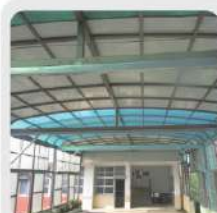
二樓連通走廊採光罩改善後
