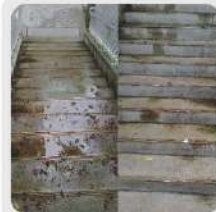
室外梯改善前
