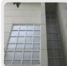
前棟教室東側樓梯改善後
