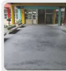
一樓連通走廊地面改善後
