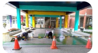
走廊壓克力漆粉刷
