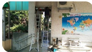
電動鐵捲門安裝
