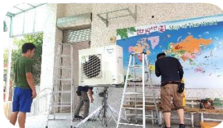
專科教室冷氣安裝
