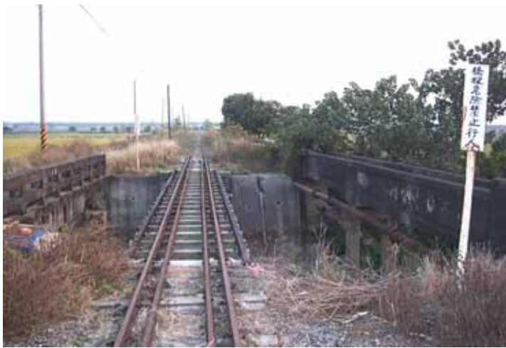
跨越田間小溪溝的台糖鐵道鐵橋。
