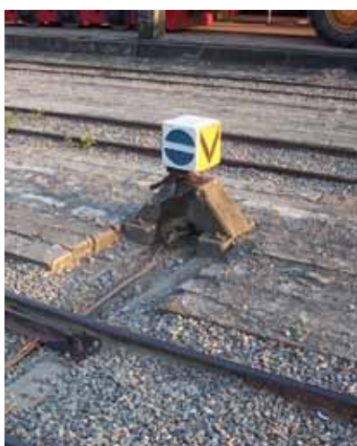
「轉撤器」黑色半圓形在上，表示軌道切換成岔線，列車行進會向左方偏行而去。
