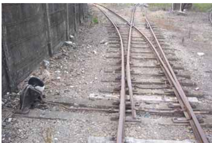
「轉撤器」黑色半圓形在上，表示軌道切換成岔線，列車行進會向左方偏行而去。
