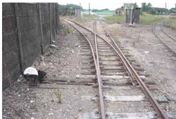
「轉撤器」白色半圓形在上，表示軌道換成正線，列車行進會以直行方向行駛。
