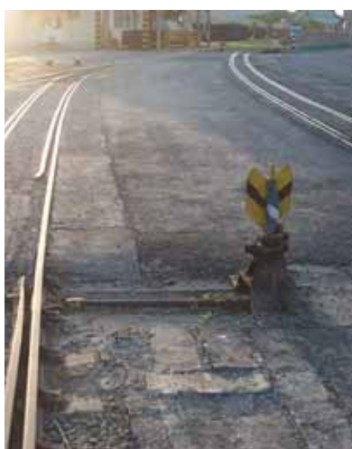
「轉撤器」黑色半圓形在上，表示軌道切換成岔線，列車行進會向左方偏行而去。
