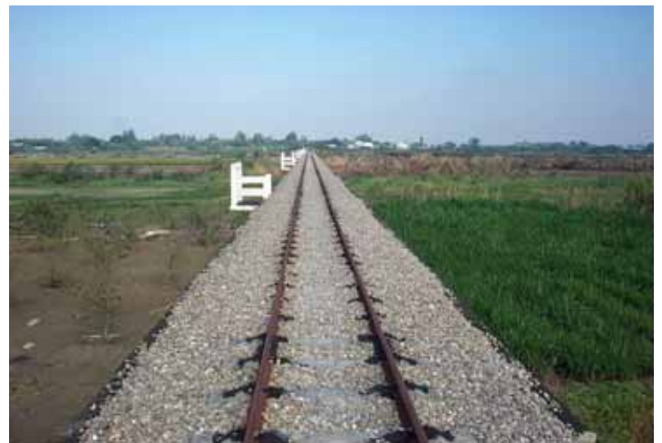
橫跨「八掌溪」的台糖鐵道鋼筋水泥結構橋樑。
